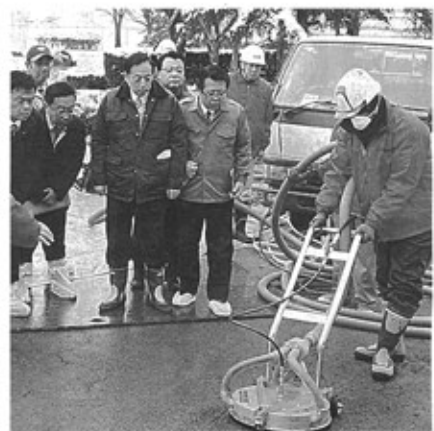
福島県郡山市での除染作業を視察（3月10日）
